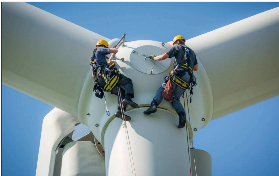
Szélérőmű beüzemelése 75 méteres magasságban. Az Európai Unió elképzeléseinek fontos eleme az innovatív, zöld beruházások ösztönzése és ezáltal a munkahelyteremtés.
